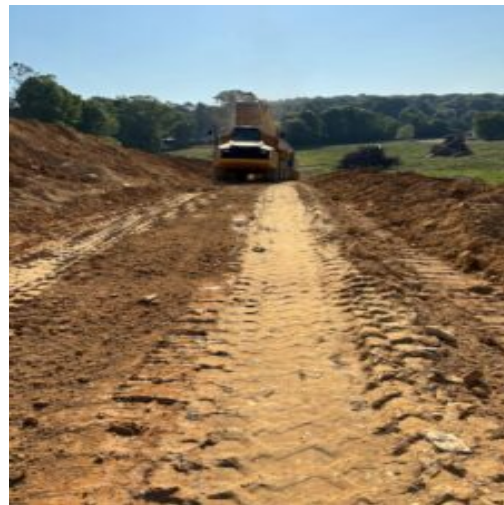
Fill placing
