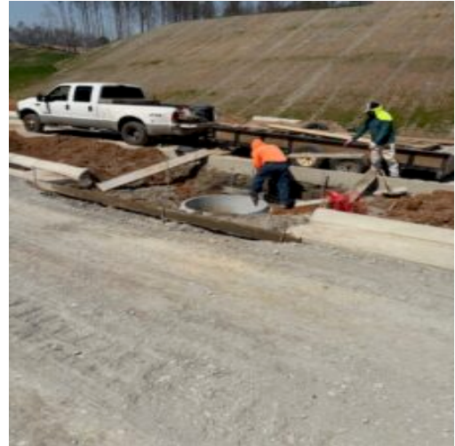
Curbing contractor forming base for inlets pour
