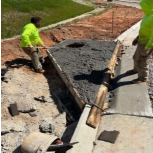
concrete pour at single wing curb inlet
