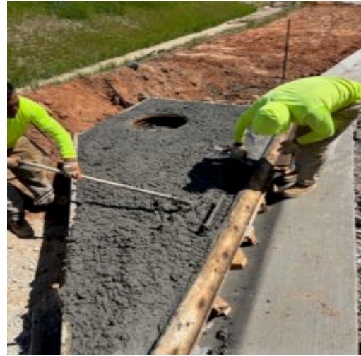
concrete pour at single wing curb inlet
