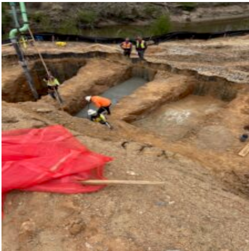
Pouring mud mat
