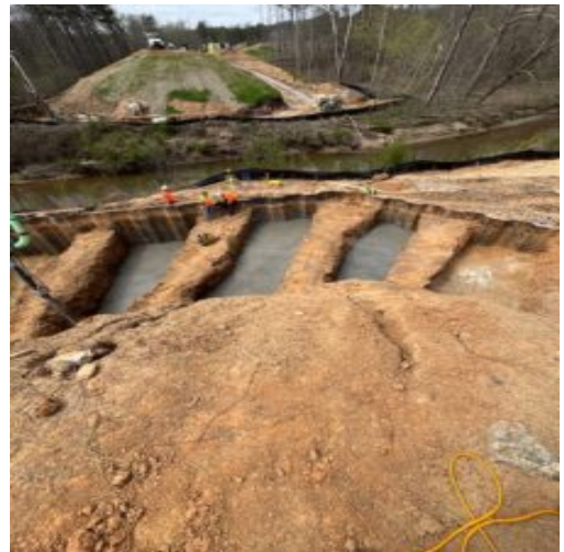
Poured mud mats
